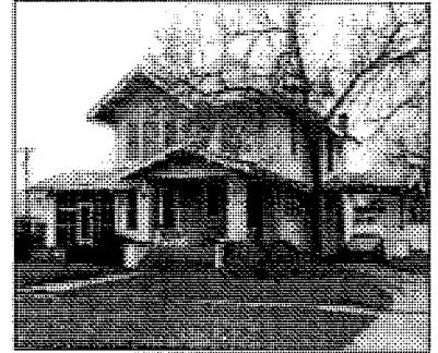
403 N. Preston (Site No. 806) c. 1909 Fain House
